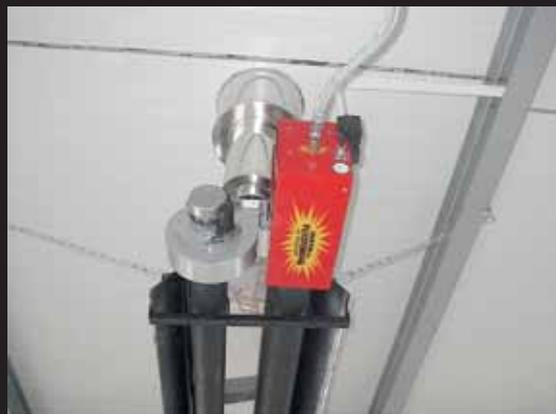
Odvod dimnih plinova izvan objekta
