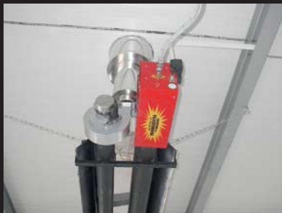
Odvod dimnih plinova izvan objekta
